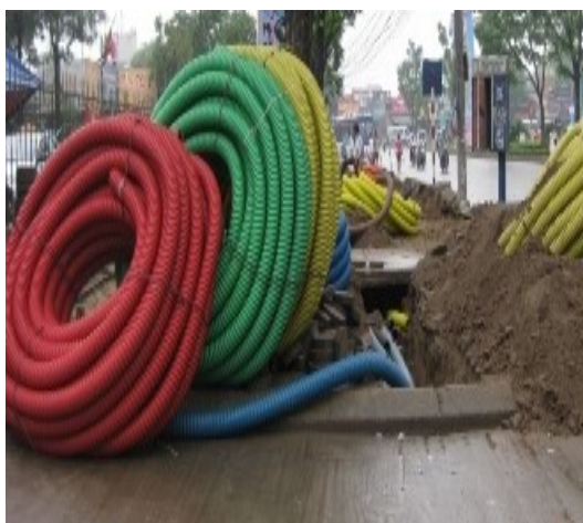
Ống gân xoắn HDPE/TBBT/UF sau khi chế tạo tại Công ty CP An Đạt Phát và ứng dụng tại hiện trường.
