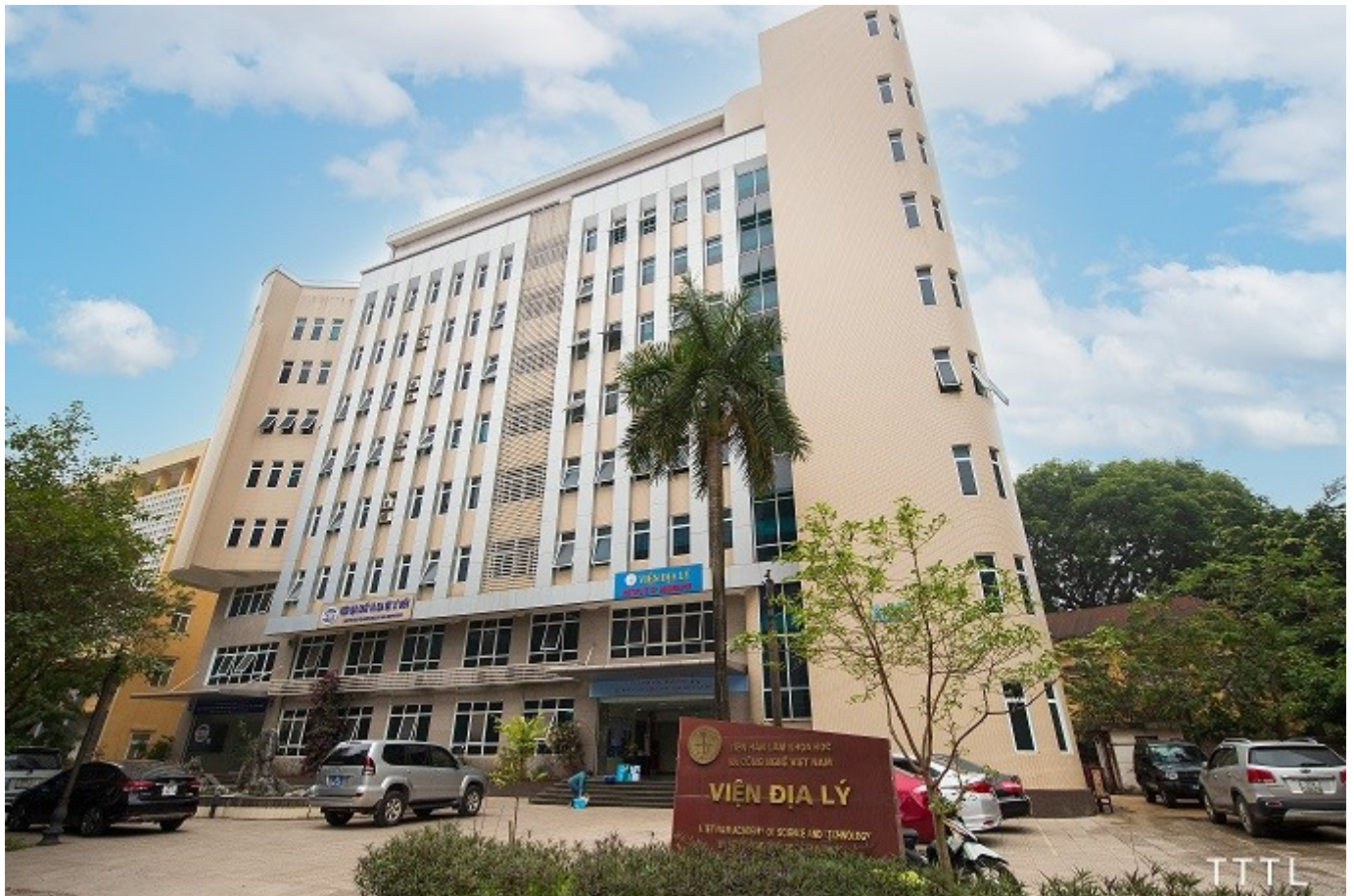
Tòa nhà Viện Địa lý, Viện Địa chất và Địa vật lý biển.
